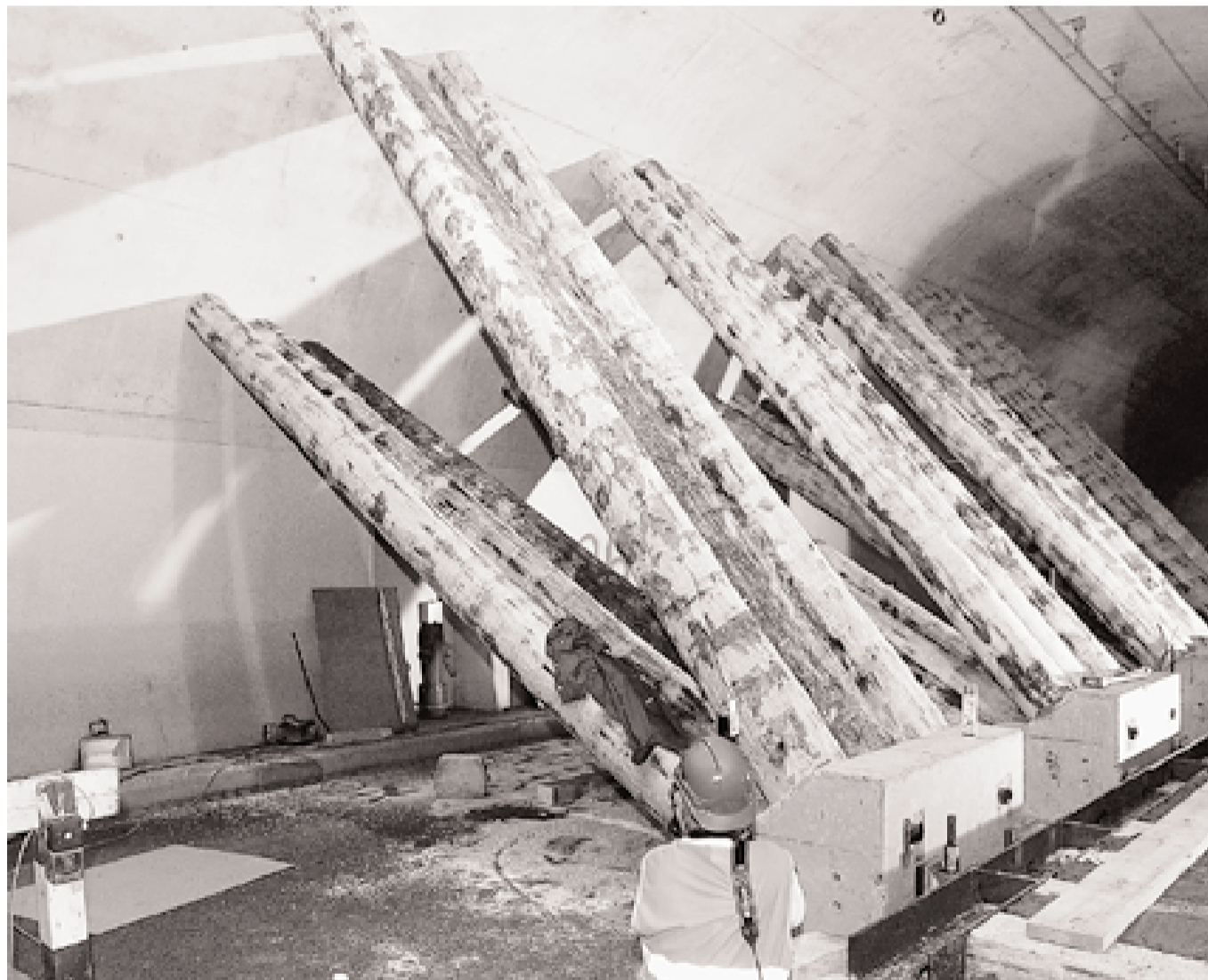
Wie schon im Nordteil müssen jetzt auch im Südteil des Mitholtunnels Holzstützen eingesetzt werden.
